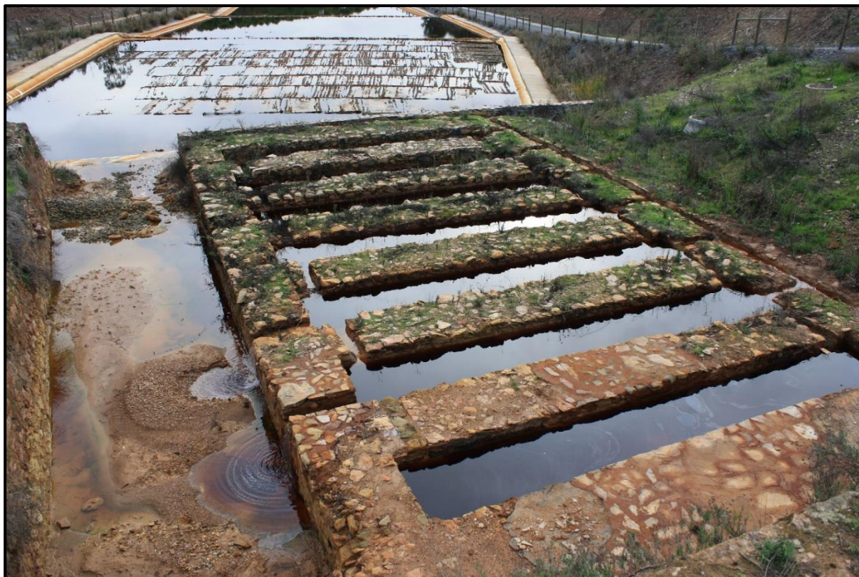
Tanques de Cementação
